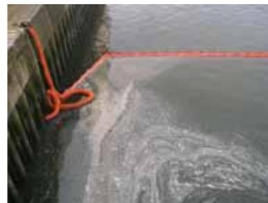
21/01 : Barrage reconfiguré et étanchéifié par absorbants (Source : Cedre)
