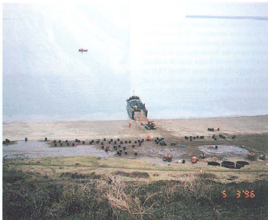
Chantier de stockage
