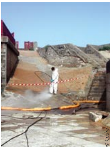
Nettoyage haute pression et filtration des effluents par un boudin, Fort de Socoa(64), juillet 2003
