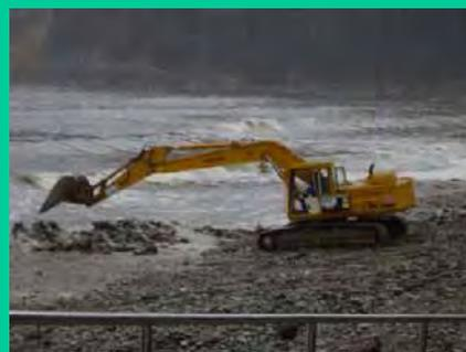
2.- Déplacements des galets vers la zone de déferlement à l'aide d'une pelle mécanique sur chenilles.
