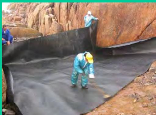
3.- Imperméabilisation du fond de la retenue avec une bâche plastique.
