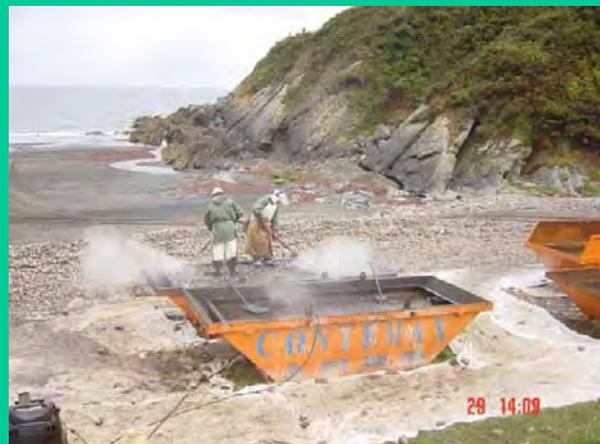
2.- Après quelques semaines d'immersion dans l'eau dans une benne, nettoyage haute pression du pétrole ramolli.
