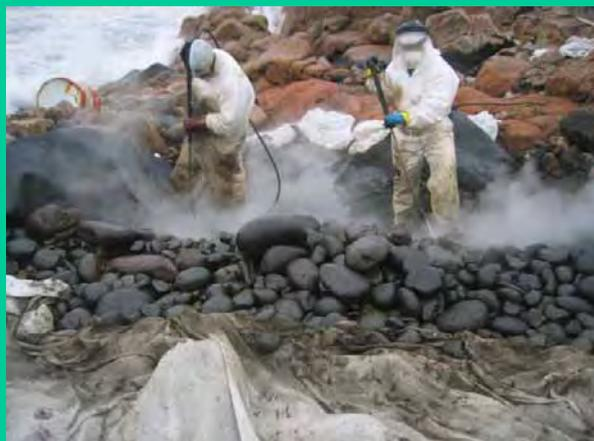
5.- Après quelques semaines, nettoyage haute pression du pétrole ramolli en surface des galets.
