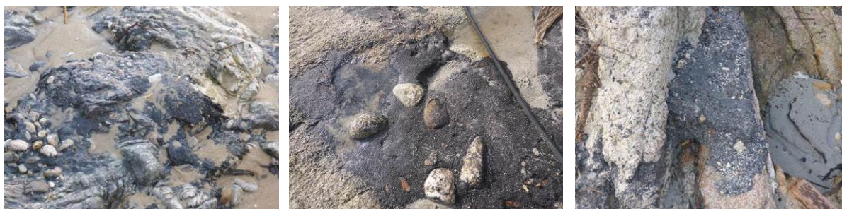
Aspects/détails des taches de pollution ancienne. Exemples sur secteurs (de gauche à droite) : Bonne Terrasse ; Pte Canadel ; plage de la Douane (Source : Cedre)
