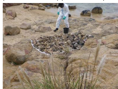
Tri de galets pollués pour nettoyage in situ en bétonnière (Source : Cedre)
