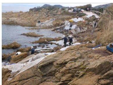
Organisation de chantiers de nettoyage en NHP (avec dispositifs de collecte des effluents, de protections contre projections, ...) (source : Cedre)
