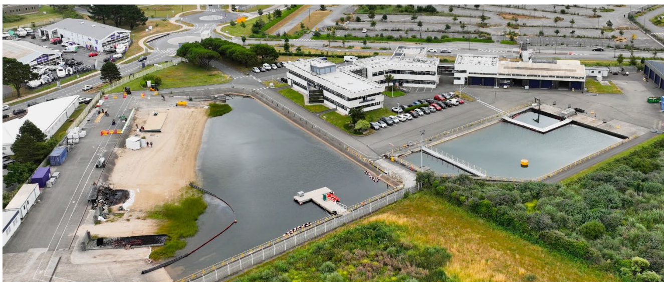
Vue aérienne du site du CEDRE – crédit photo Focale Fixe
