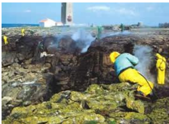
Bataille worksite – Pilier island (Vendée) ©CHANU
