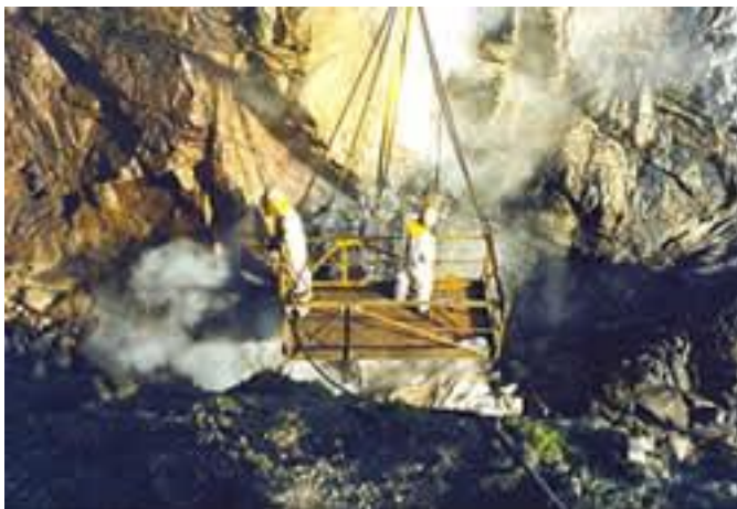
Nettoyage haute-pressure de falaises au chantier FOSELEV/SIS (44) ©CEDRE
