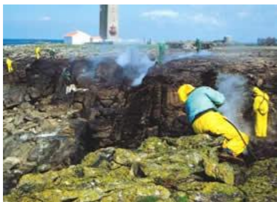
Chantier Bataille – Ile du Pilier (85) ©CHANU
