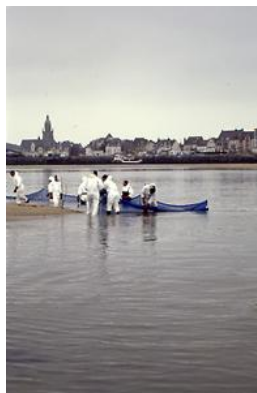
Pose de filets pour la récupération des effluents de nettoyage ©CEDRE
