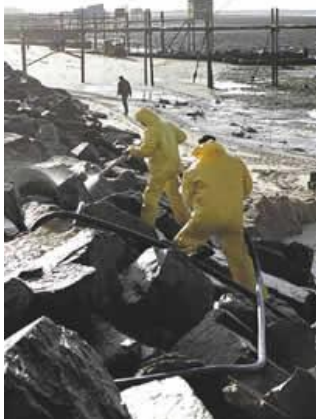
Lavage d'enrochements à Moutiers ©CEDRE
