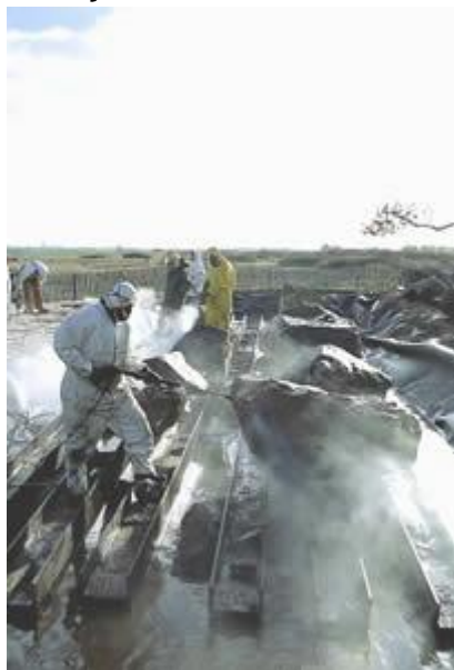
Chantier Le Floc'h Dépolution – La Bernerie (44) ©CEDRE
