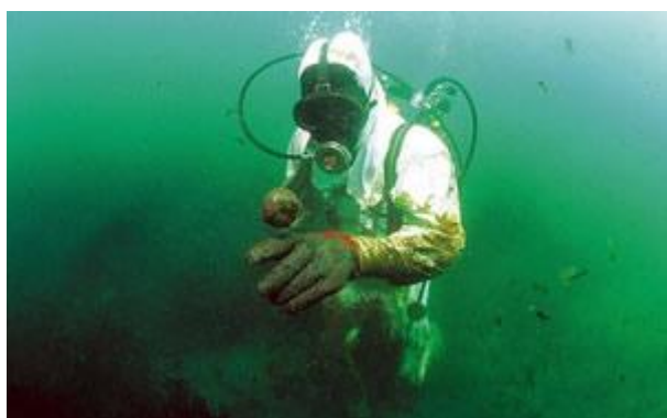
Traitement d'une nappe immergée à Belle-Ile en mer ©CEDRE
