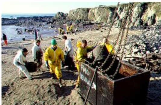
Evacuation des déchets dans une crique en pied de falaise (inaccessible aux engins lourds) : les seaux sont vidés dans une benne qui sera ensuite ...©CEDRE
