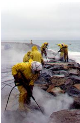
Nettoyage d'enrochements au nettoyeur haute-pression ©CEDRE
