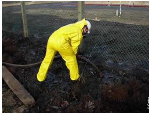
Pompage des accumulations à l'extérieur du dépôt ©CEDRE
