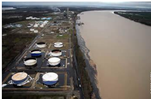
Vue aérienne du dépôt et de la nappe sur la Garonne, le 12/04/07 ©TASO/SPBA
