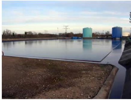
Pétrole accumulé dans le décanteur ©CEDRE
