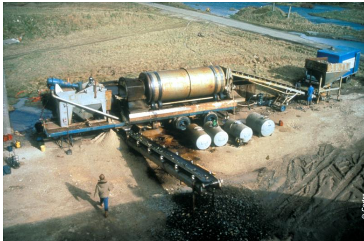
Centrale mobile de lavage des galets ©CEDRE
