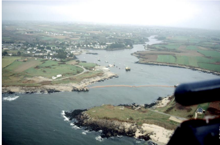
Protection de l'Aber Benoit avec la mise en place d'un barrage ©CEDRE
