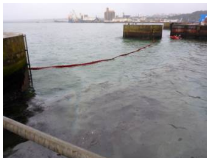
Barrage SDIS en bout du quai QR5 (gauche) ; Pompage des nappes piégées par camion hydro-cureur (droite) (Source : Cedre)
