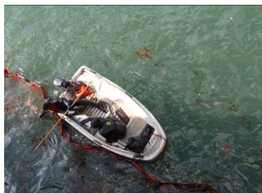
Récupération manuelle d'absorbants souillés dans la poche de confinement (Source : Cedre)
