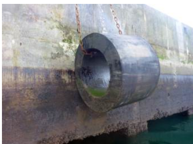
Pollution de la surface poreuse des longrines béton sous le tablier de quai (gauche) ; Bande horizontale sur face externe de quai et défenses (centre) ; Dépôts et tâches de fioul en partie haute des enrochements (droite) (Source : Cedre)
