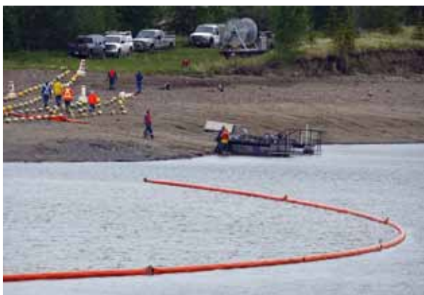
Pose préventive de barrages sur le réservoir de Gleniffer à proximité de Sundre (Alberta) © Plains Midstream
