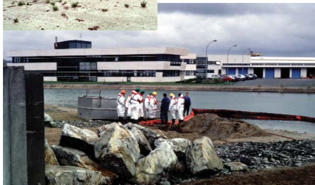
Mise en oeuvre des décisions du CIADT : formation pratique par l'équipe pilote d'intervention-formation et suivi de travaux de restauration environnementale
