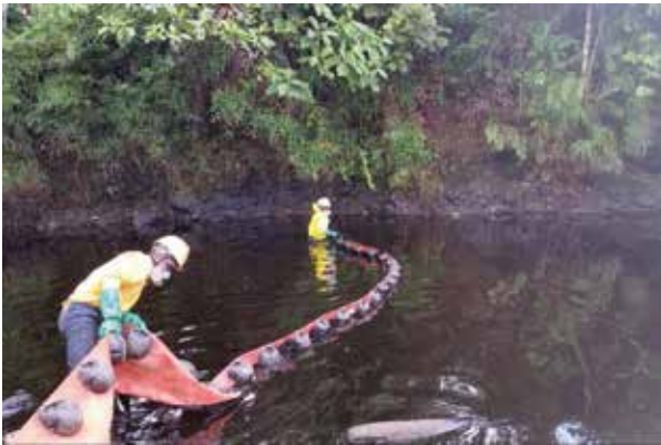
Déploiement de barrages sur le Rio Guisa , à proximité de l'oléoduc de Tumaco (Source : inteligenciapetrolera.com.co )
