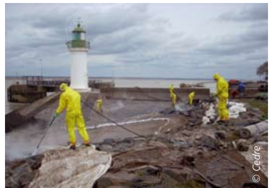
Opération de nettoyage à Paimboeuf
