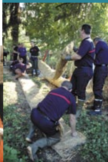
Formation pratique en eaux intérieures : montage d'un barrage de fortune
