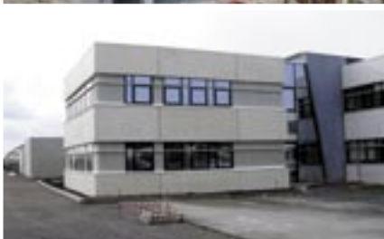
Travaux d'extension du bâtiment
