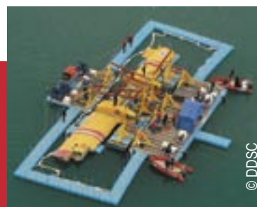
Méditerranée : relevage d'un canotier accidenté avec mesures de prévention des fuites de carburant et d'huile
