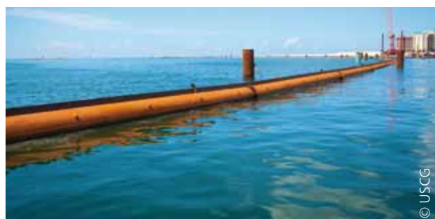
Barrages flottants fixés à des pieux
