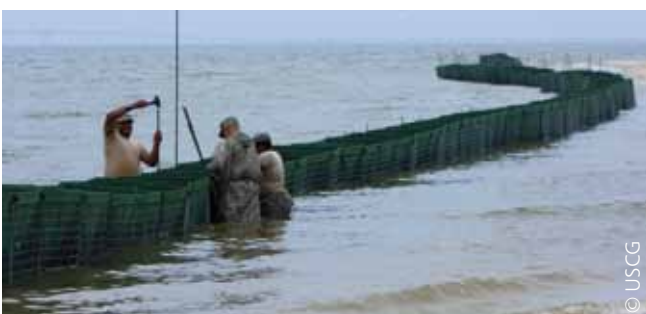
Les gabions remplis de sable
