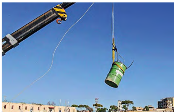
用起重機吊起桶子。
