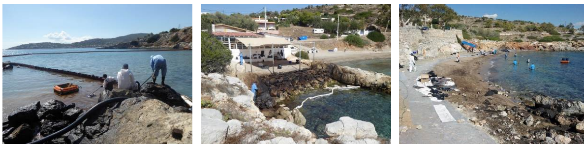
J+1 mois, Ile de Salamine : Rinçage en basse pression des accumulations de fioul sur roches littorales, et récupération par tête d'écémage oléophile ( Gche ) ; Chantier de nettoyage, en haute pression, d'encrochement avec récupération des effluents par absorbants ( Ctre ) ; Collecte manuelle d'amas submergés en avant-plage (prof. 1 m environ) ( Drte ) (Source : Cedre )
