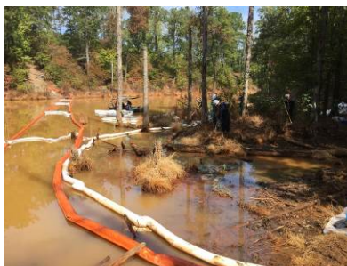
Gauche : chantiers de confinement/ récupération d'accumulations d'essence contre les berges ; Droite : aire de stockage des déchets liquides en « Frac Tanks », en arrière chantiers (Source : USEPA)
