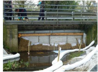
Dispositif filtrant (paille et absorbants dans structure grillagée) à 1,5 km à l'aval du point de fuite (Source : Cedre)
