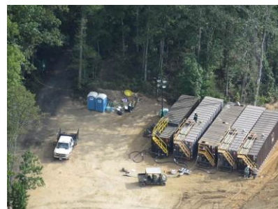
Gauche : chantiers de confinement/ récupération d'accumulations d'essence contre les berges ; Droite : aire de stockage des déchets liquides en « Frac Tanks », en arrière chantiers (Source : USEPA)
