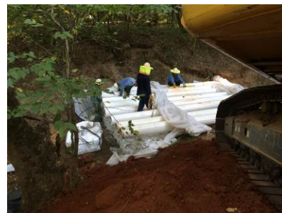
Gauche : secteurs de fortes accumulations d'essence dans le bassin pollué, d'apparence orangée ; Droite : construction de talus busés au niveau d'un déversoir naturel d'étang (Source : USEPA)
