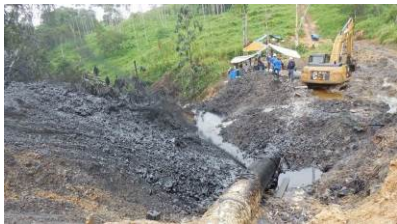
Vue de la section fuyarde du Norperuano Pipeline (Source: OEFA)
