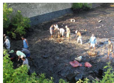
Gauche : Rinçage en basse pression de substrats durs (calcaires) et récupération des effluents par absorbants conditionnés ; Droite : Récupération manuelle des accumulations de polluant et des débris pollués (source : ITOPF)
