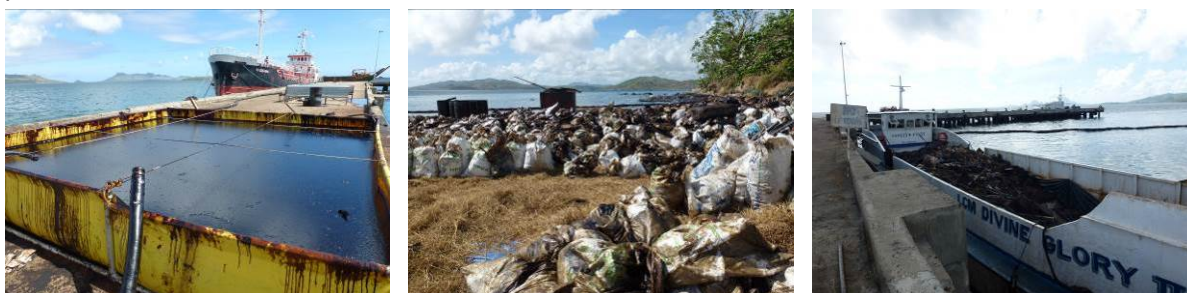
Gauche : stockage du fioul récupéré dans et autour de la barge PB103, avant transfert vers le pétrolier Obama (arrière-plan) ; Centre : sacs de déchets souillés ; Droite : barge mobilisée pour l'évacuation des déchets solides (source : Cedre)
