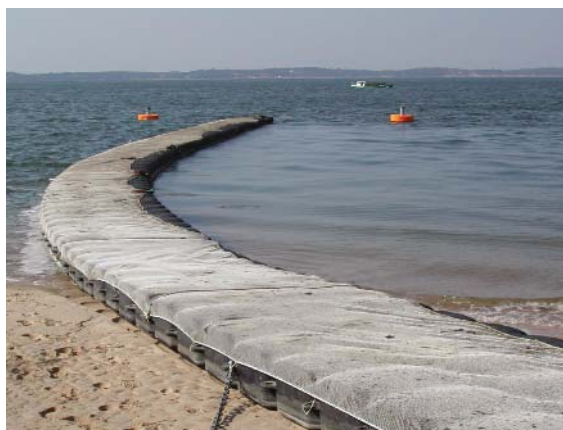
Protection par épis fixe à Arcachon pendant la pollution du Prestige
