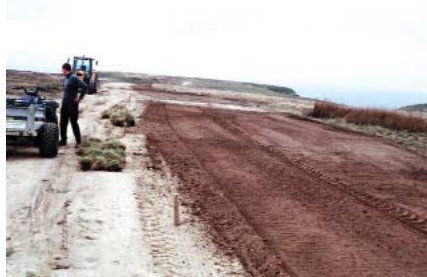
Restauration de site à Belle-Ile. En haut, sentier élargi dans la lande (2002) En bas : labourage superficiel puis implantation de mottes de végétation (2003)
