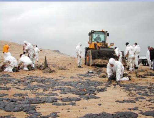
Collecte manuelle de plaques et évacuation par engin
