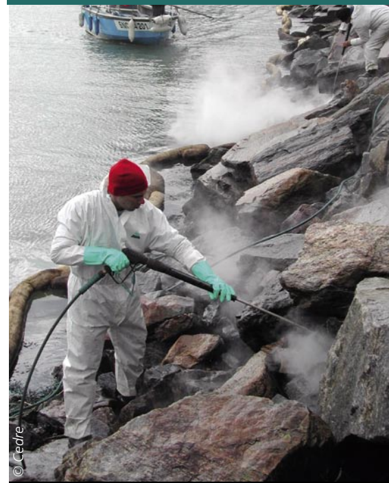
Chantier de nettoyage rive sud
