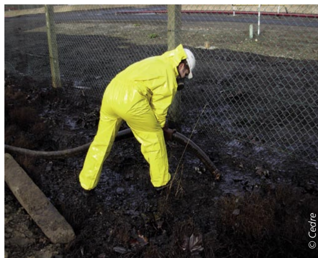
Pompage des accumulations à l'extérieur du dépôt
