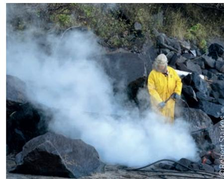
^ Nettoyage à haute pression et à l'eau chaude sur des berges en enrochement
