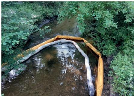
^ Barrage et absorbants mis en place par le SDIS de l'Oise au niveau du pont de la D909
