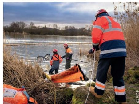
^ Captation de résidus d'hydrocarbures et expertise au niveau du barrage flottant à la station de rejet du site
